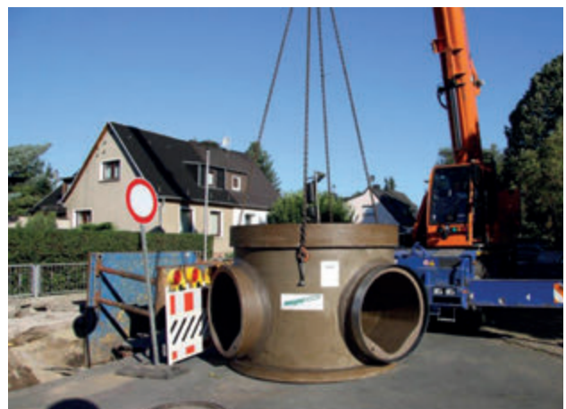
POLYCRETE® regard circulaire pour tubes avec cunette intégrée
