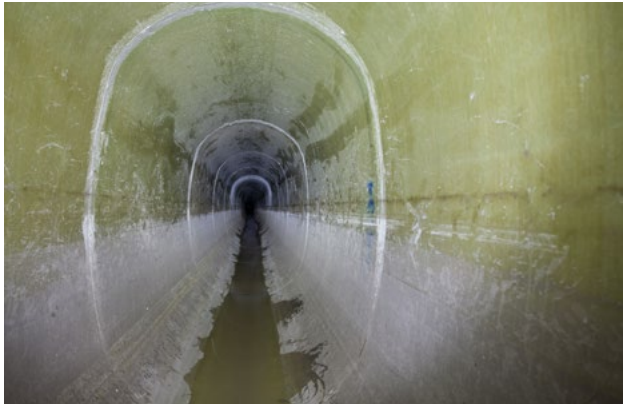
Chemisage d'égout par des tubes RPR ovales
