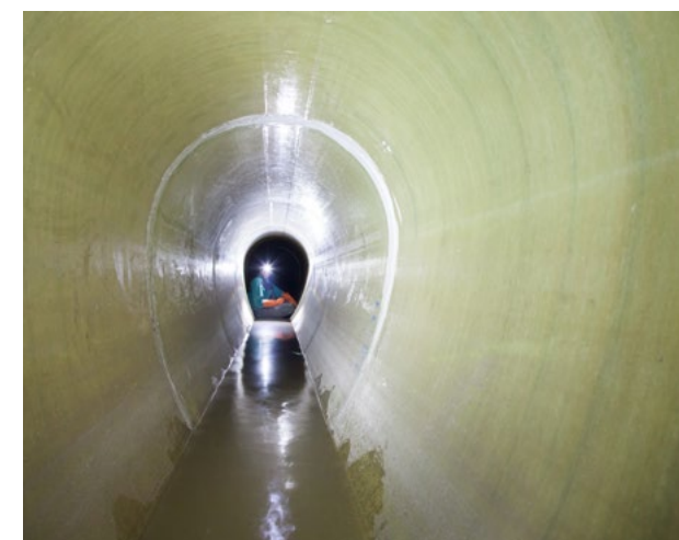
Réhabilitation d'un collecteur visitable à l'aide d'un ovoïde PRV
