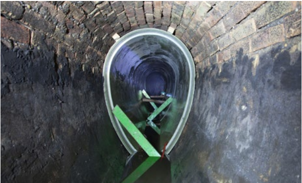
Réhabilitation sans tranchée avec un profil PRV à section ovoïde
