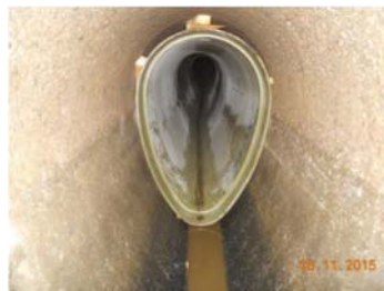
Figure 1 : Principe de réhabilitation par coque complète.
